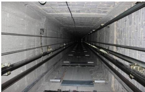
2013年5月，贵州省某县法院受理一起合同纠纷案件，原告某房地产开发公司向被告某楼宇设备有限公司购买的电梯在安装后运行时开关门出现摩擦音大、滑梯、轿厢门与楼层边框不齐、运行晃动明显、电梯关人等现象，严重影响到原告的声誉和楼盘业主的正常出行。为此，本案原告向法院提出司法鉴定申请，要求对涉案电梯安装运行过程中出现的故障原因进行鉴定。
